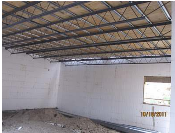
Afbeelding 8: Metalen vakwerliggers voor vloeropbouw. © http://energyefficientbuild.blogspot.be
