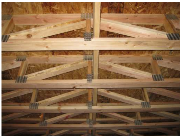
Afbeelding 7: houten vakwerkliggers gebruikt voor een vloer. © http://tawnaallred.com
