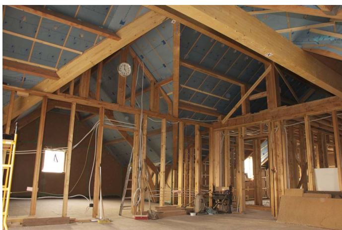
Afbeelding 1: Laag energie houtskelet woning. ©Pieter Maes
