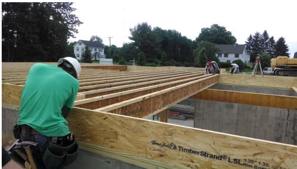
Afbeelding 4: installatie van vloer op kelder met I-joist, lichtgewicht houten profielen. © http://www.reserveatfarmview.com
